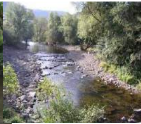
Arasement partiel ou total de l'ouvrage
