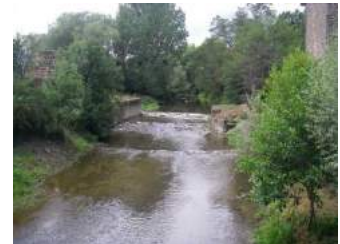
Démantèlement de l'ouvrage et travaux d'accompagnement défini avec le propriétaire.
