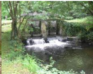
Ouverture prolongée des vannes de moulin
