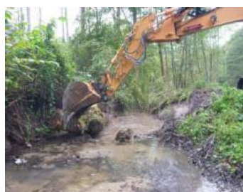
Réouverture et fixation dans le lit du cours d'eau
