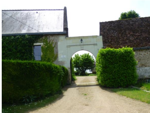
Portail, façon porche, de la Roberdière
