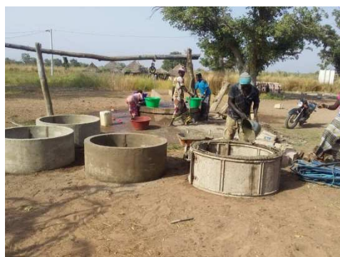
(fabrication et pose de 8 buses en béton pour le chemisage du puits à Sare-Goubou)
