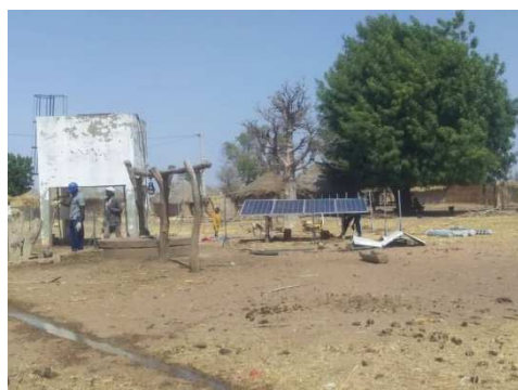
(Installation d'une pompe à énergie solaire par l'entreprise Soleil Eau Vie basée à Dakar)
