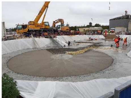
Travaux de la bache à boues
