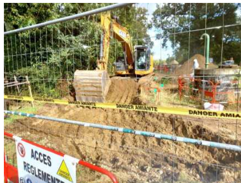
(pelle mécanique pour le ramassage des débris)
