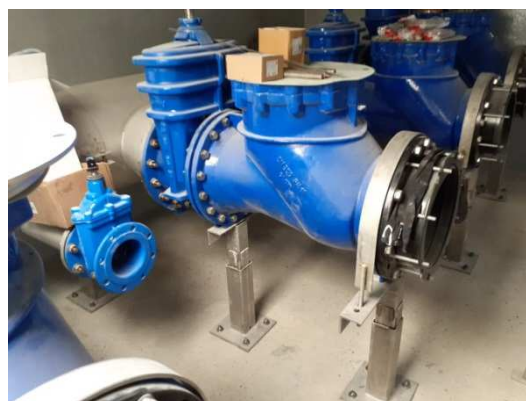
Pose de vannes au poste Sud
