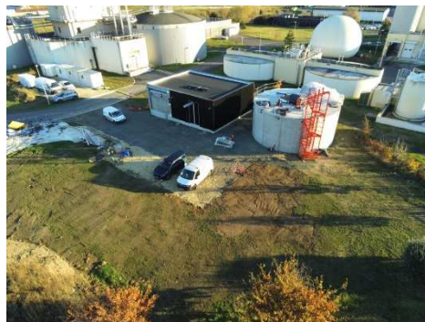
Travaux local pompe à chaleur
