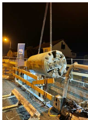
Retrait du micro-tunnelier
