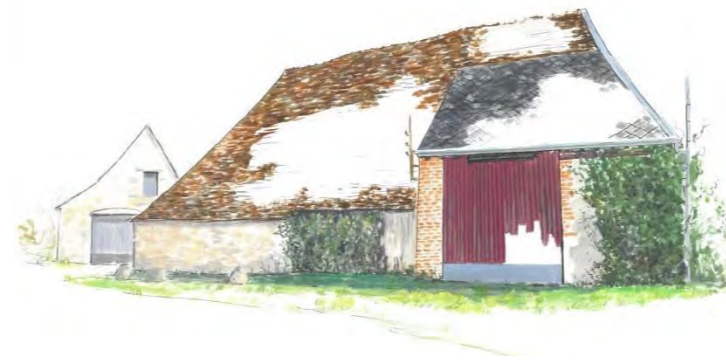
Importance de la couverture en tuile et de l'entrée au regard de la partie maçonnée.
