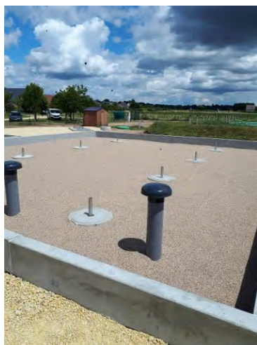
les lits filtrants avant plantation des roseaux
