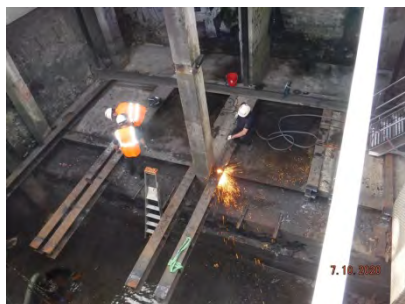
Démontage support pied d'assise
