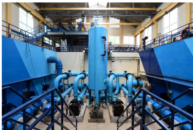
Station de l'île Aucard : arrivée des puits et de l'anti-bélier
