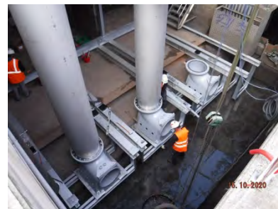
Mise en place de conduite verticale de refoulement
