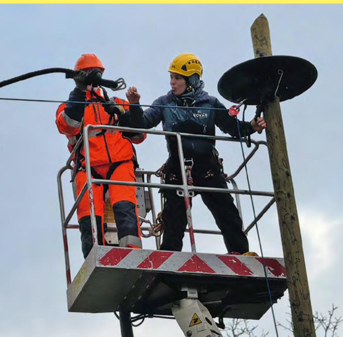
Installation de l'écuroduc à Rochecorbon.
